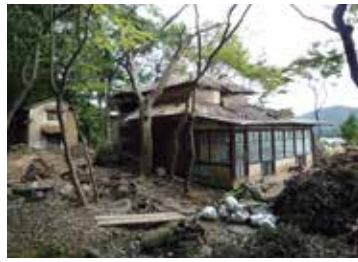
写真5 改修前の外観
